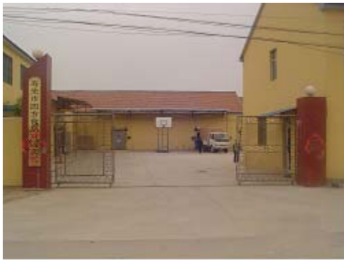
<당근 가공공장 전경>
